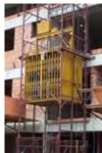
Figura 62 – Foto de elevador à cabo de aço
