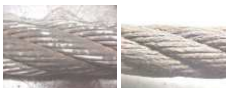
Figura 25 – Corrosão em cabos de aço
