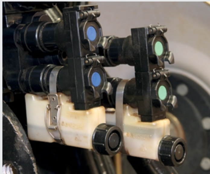
Figura 139 – Reservatório para recolher possíveis vazamentos de óleo.
